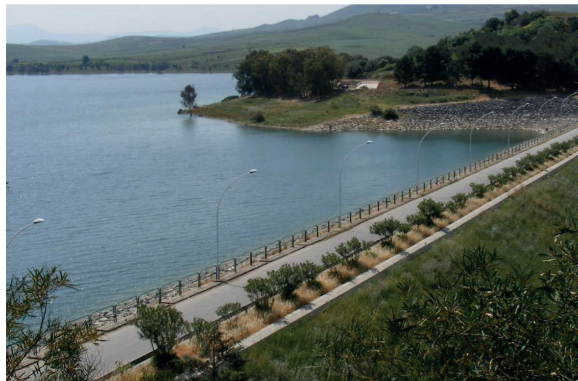
Fig. 9 e 10 - Sopra: paramento di valle; sotto: strada sul coronamento dello sbarramento
