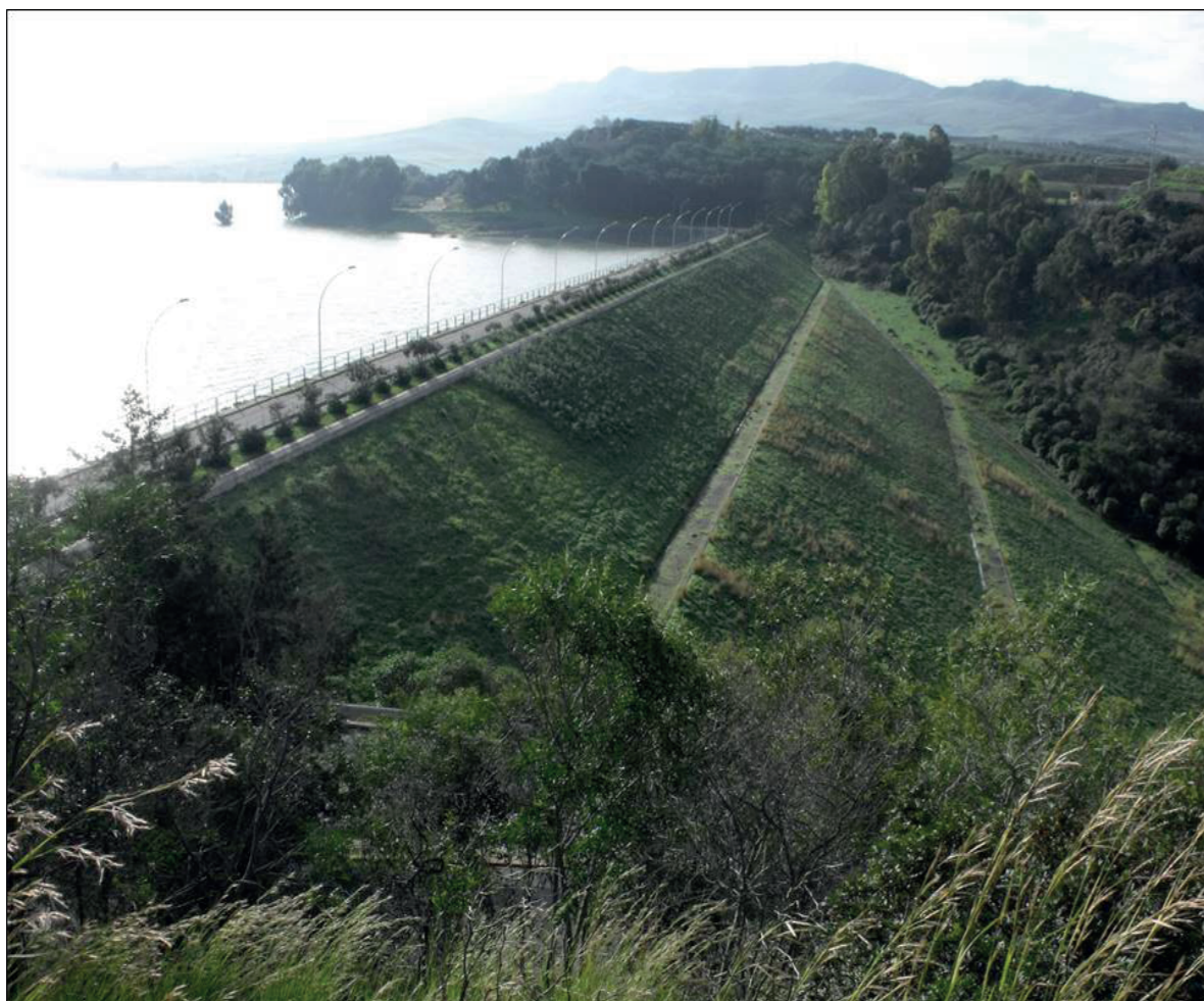
Fig. 9 e 10 - Sopra: paramento di valle; sotto: strada sul coronamento dello sbarramento
