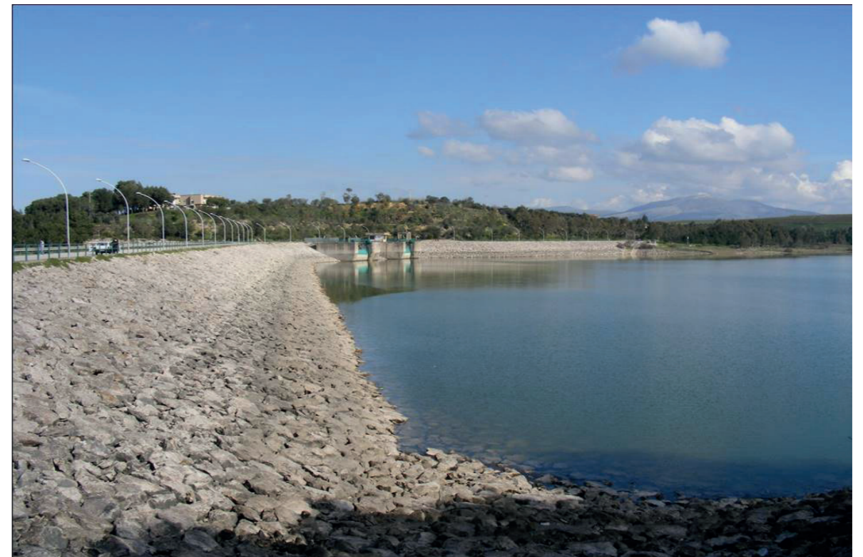
Fig. 5 e 6 - Sopra: lato nord-ovest dell'invaso Poma; sbarramento, paramento di monte con coronamento e scarichi di superficie. Sotto: Sezione trasversale e schema dei materiali che formano il corpo della diga
