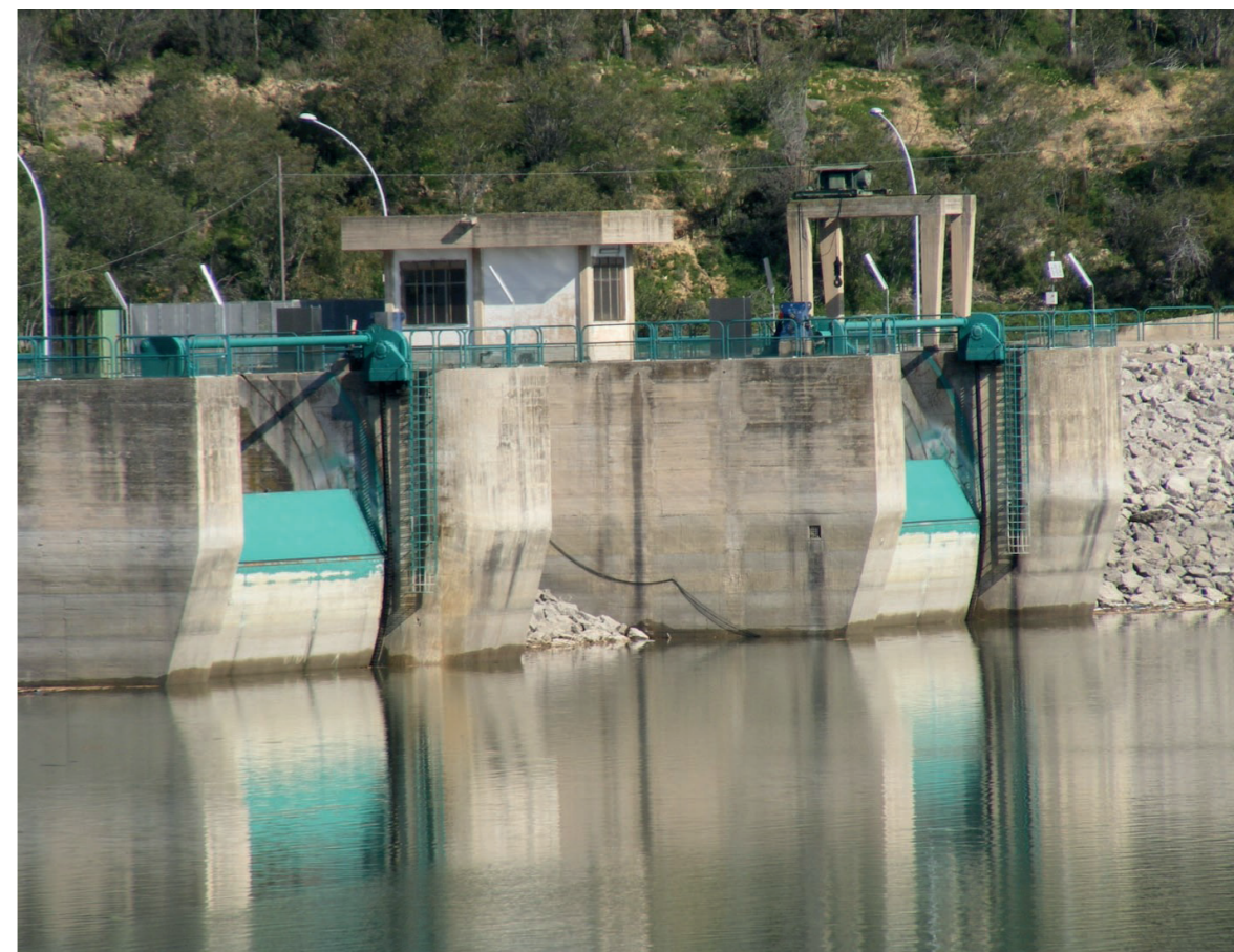
Fig. 7 e 8 - Sopra: scarichi di superficie con paratoie e ventole; sotto: canale di captazione delle acque del Nocella
