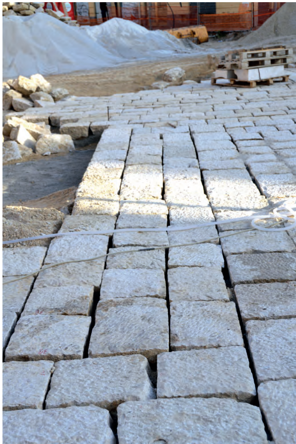
Fig. 16 - Foto del nuovo basolato durante la posa in opera, è evidente la mancanza di un unico allineamento delle basole, oltre che varie irregolarità tra i quali la larghezza variabile delle fughe, peraltro non previste del basolato originale.
