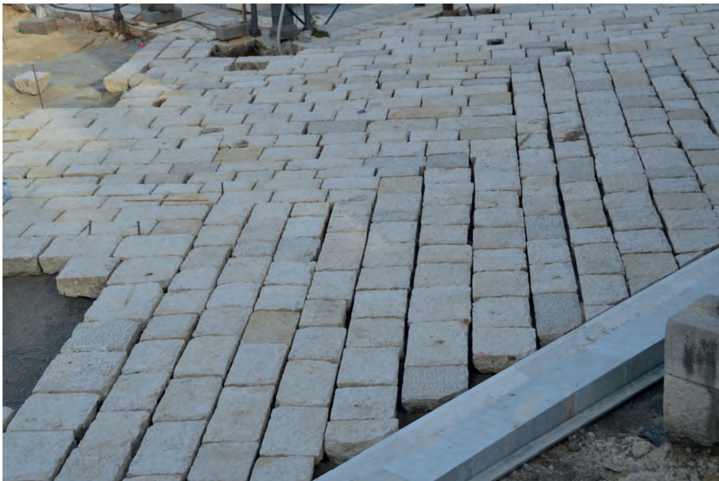
Fig. 27 - La foto evidenzia la mancata cura per i dettagli; è totalmente impropria la finitura superficiale che doveva essere finalizzata a migliorare l'aderenza al calpestio. Risulta ostile all'uso, perché irregolare e non sufficientemente levigata a tale azione..
