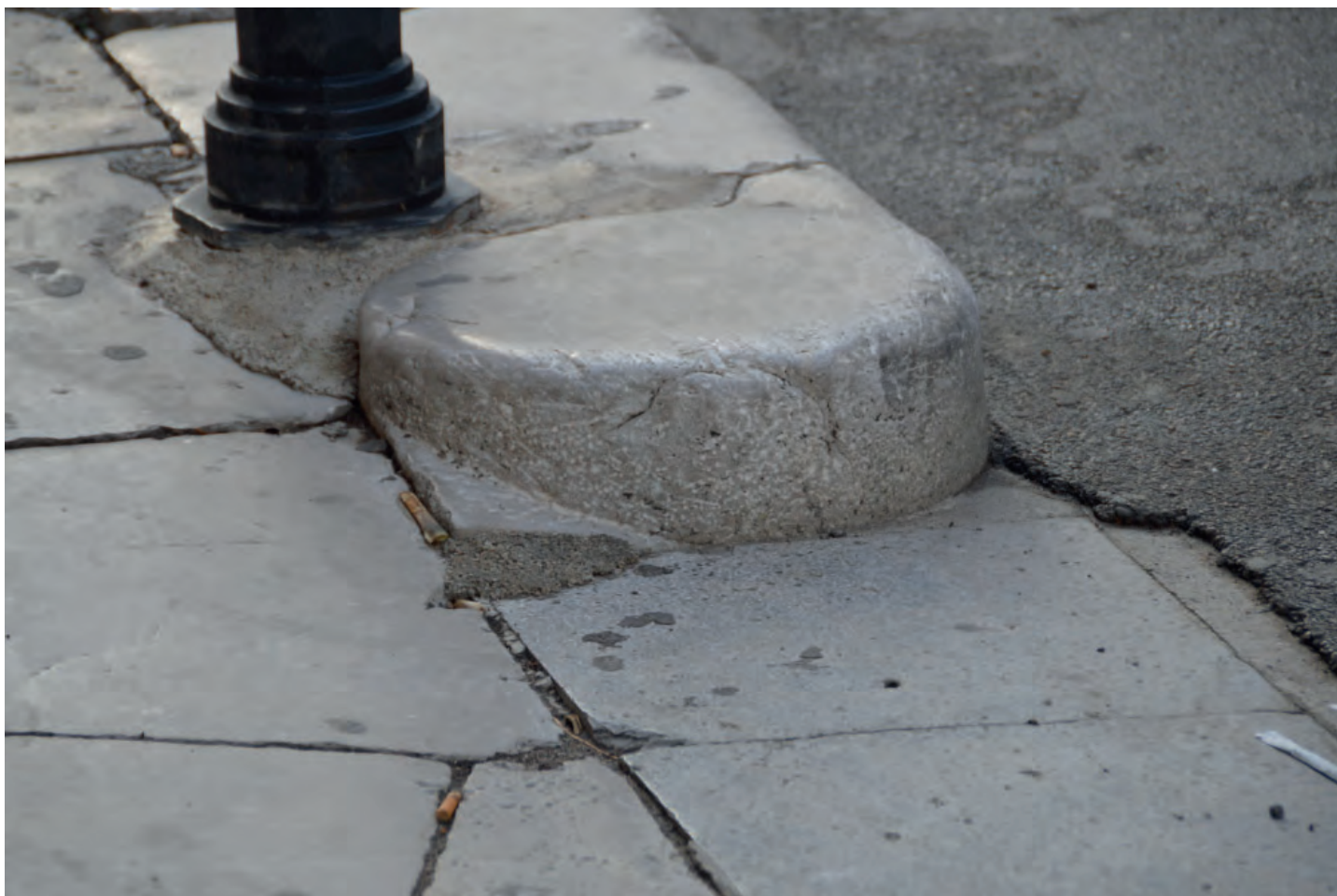
Fig. 17 - Particolare dell'antico basolato in corrispondenza di una soluzione di continuità
