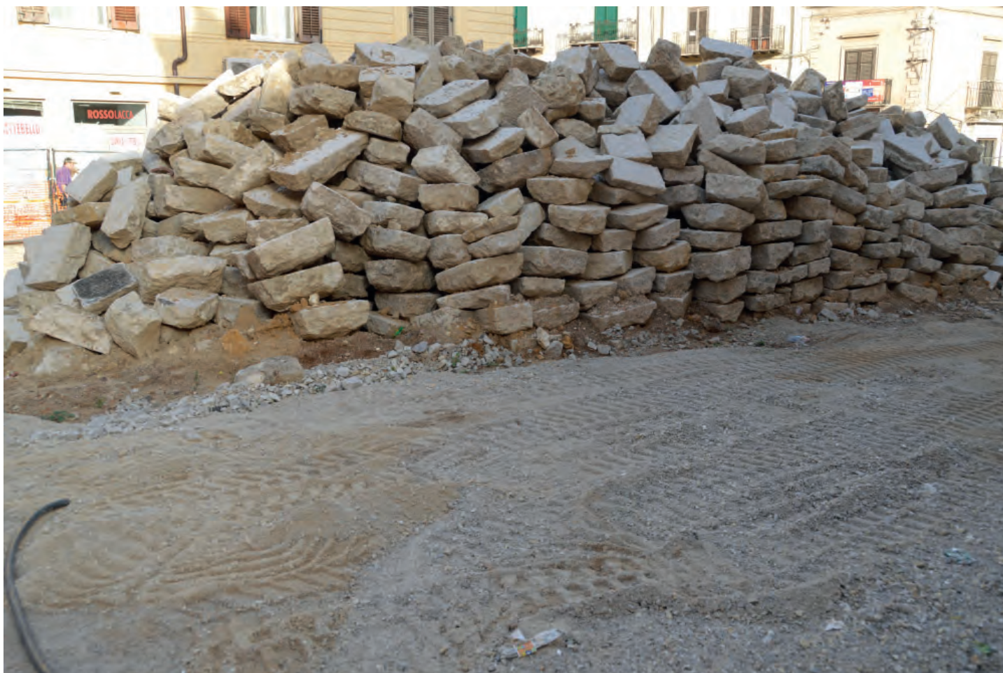
Fig. 13 - I cumuli di basole accatastate alla rinfusa lasciano presupporre la mancata georeferenziazione di ciascuna basola, al fine della sua ricollocazione nella posizione storica di competenza, come riportato nei manuali di restauro.
