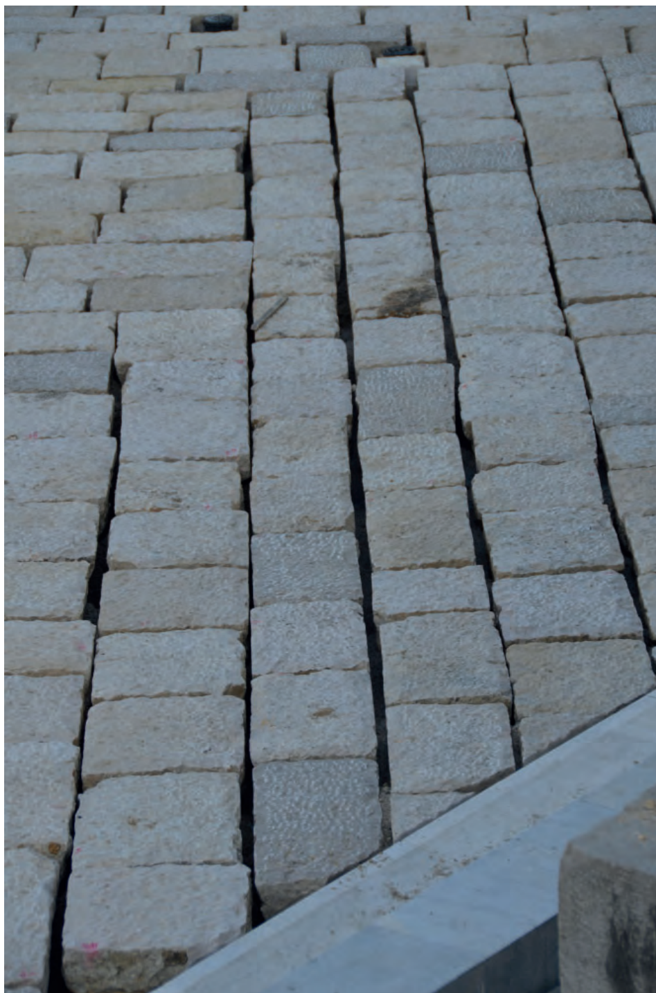
Fig. 10 -Il nuovo basolato posto in opera nel 2022. La foto documenta l'accostamento di basole che, a causa delle larghezze diverse, non permettono di ottenere un allineamento uniforme. Questa configurazione rende necessaria la realizzazione di una fuga di dimensioni variabili, determinando un ordito pavimentale di dubbio gusto estetico e notevoli difficoltà deambulatorie, soprattutto per i disabili.
