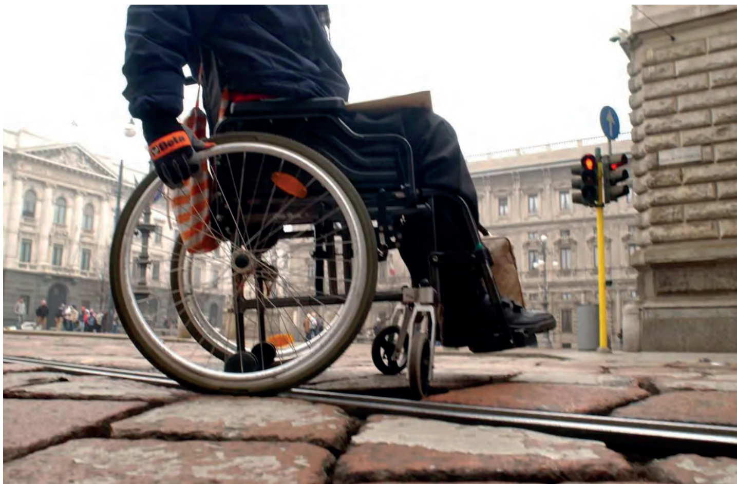
Fig. 12 - Il basolato di una piazza, realizzato senza considerare le norme sull'abbattimento delle barriere architettoniche, rappresenta di fatto un ostacolo alle disabilità.
