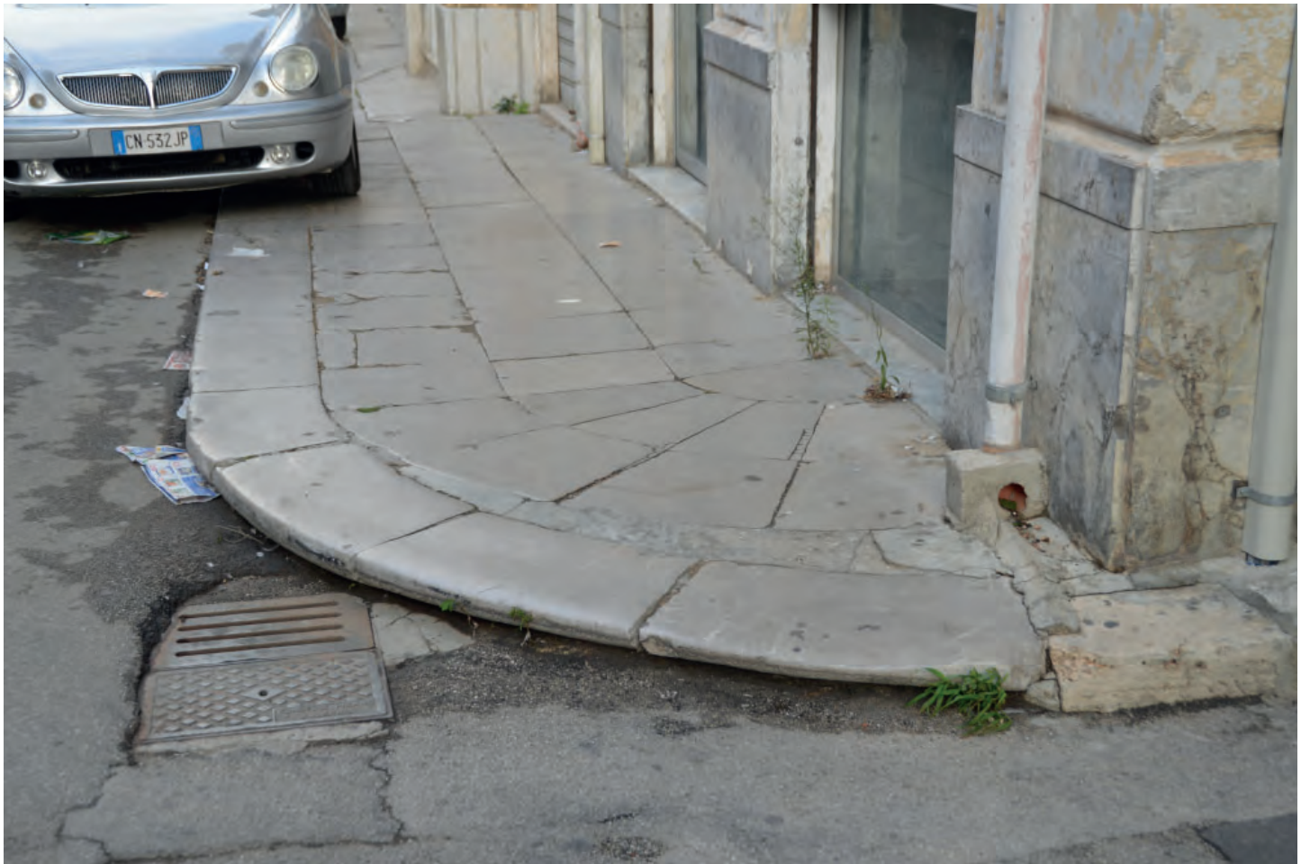
Fig. 32 - - Cordolo d'angolo in materiale lapideo a sezione toroidale del marciapiede detto "torello", si nota l'abilità dei antichi lavoratori della pietra nel sagomare la sezione del cordolo.
