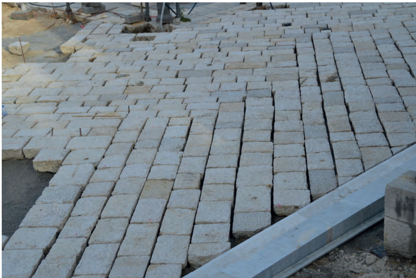
Fig. 9 - Il nuovo basolato posto in opera nel 2022. La foto documenta l'accostamento di basole che, a causa delle larghezze diverse, non permettono di ottenere un allineamento uniforme. Questa configurazione rende necessaria la realizzazione di una fuga di dimensioni variabili, determinando un ordito pavimentale di dubbio gusto estetico e notevoli difficoltà deambulatorie, soprattutto per i disabili.
