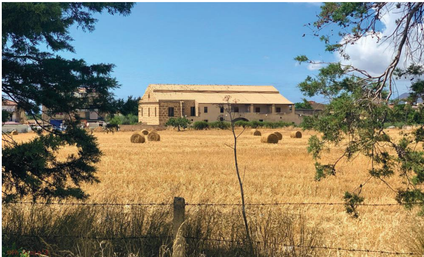
Fig. 3 - La Real Cantina Borbonica (foto di Vincenzo Saputo)
