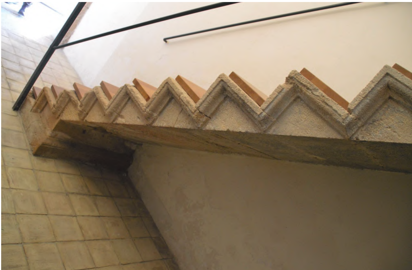
Fig. 36 - Profilo della scala in pietra monoblocco
