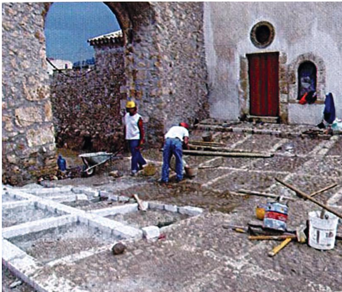
Fig. 34 - Il restauro della pavimentazione lapidea del Baglio Sanches
