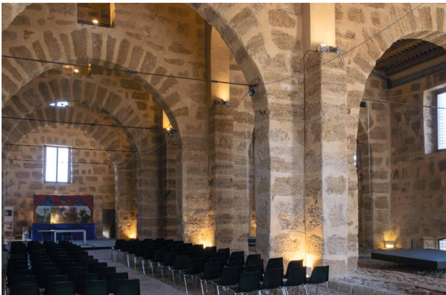
Fig. 6 - Il vano sinistro del magazzino
