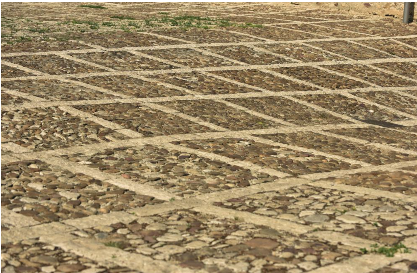
Fig. 35 - Pavimentazione esterna, oggi
