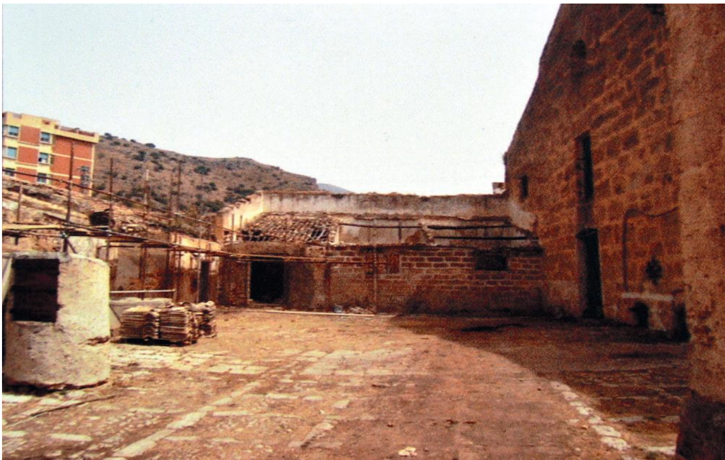
Fig. 45 - La stalla-loggiato prima del restauro
