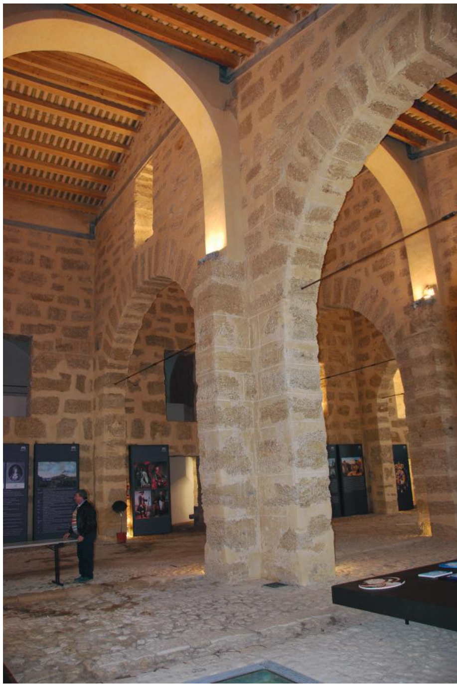
Fig. 9 - Uno degli incroci con il moncone predisposto alla realizzazione di un altro arco
