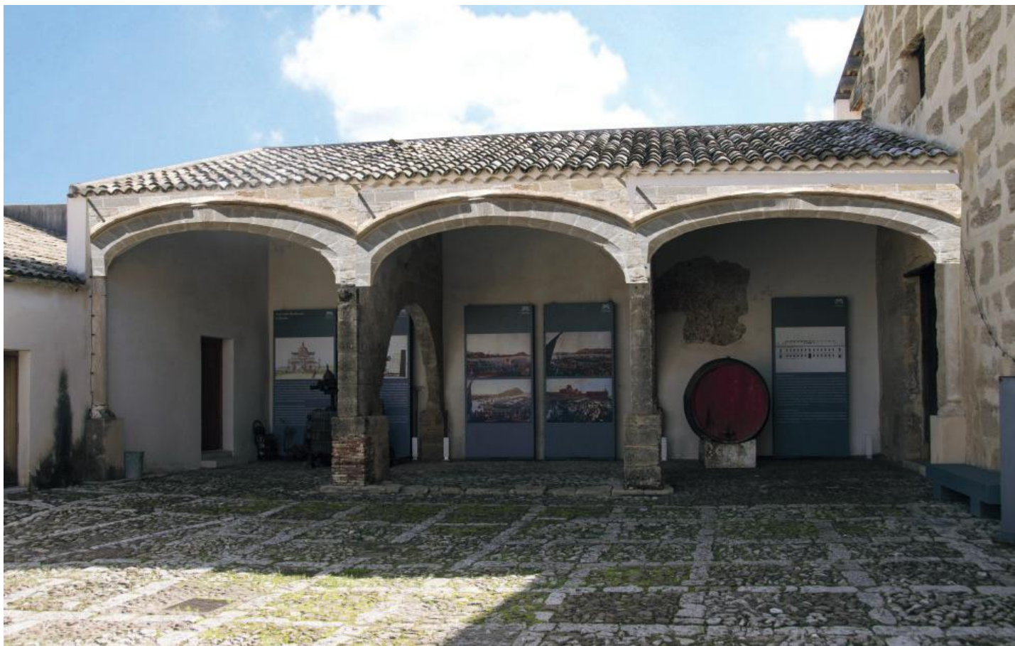
Fig. 46 - Il loggiato dopo il restauro in un fotomontaggio con i possibili archi in pietra
