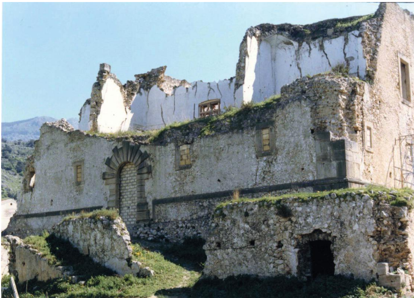
Fig.21 - Lo stato del Palazzo prima del restauro consente di vedere che si accedeva per mezzo della porticina esistente sul fronte destro e che non esistevano le finestre feritoie che si vedono oggi
