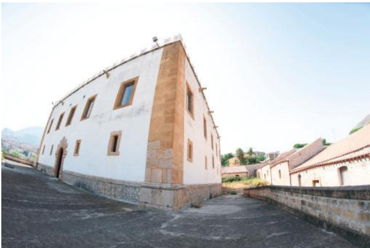
Fig. 24 - Lo scivolo che permette, oggi, di arrivare all'ingresso del Palazzo senza passare dalle due rampe di scale (Foto di Paolo Russo)
