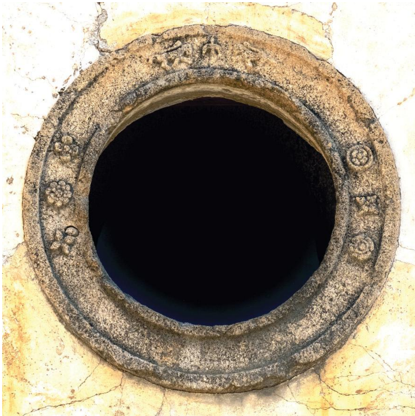
Fig. 42 - L'oculo ricavato da un unico blocco di pietra che funge da chiave dello pseudo arco che sovrasta il portale
