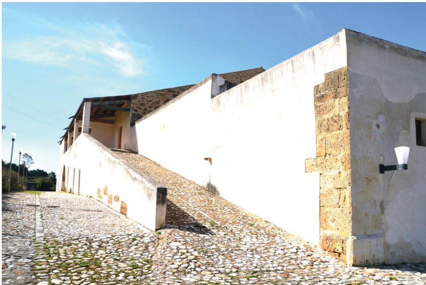
Fig. 10 - Il primo piano inclinato ovvero la rampa che permetteva di portare l'uva al punto di lavorazione
