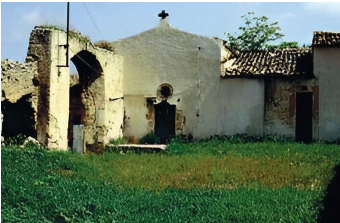
Fig. 19 - La chiesetta adibita alla lavorazione del latte (foto di Enzo Bommarito)
