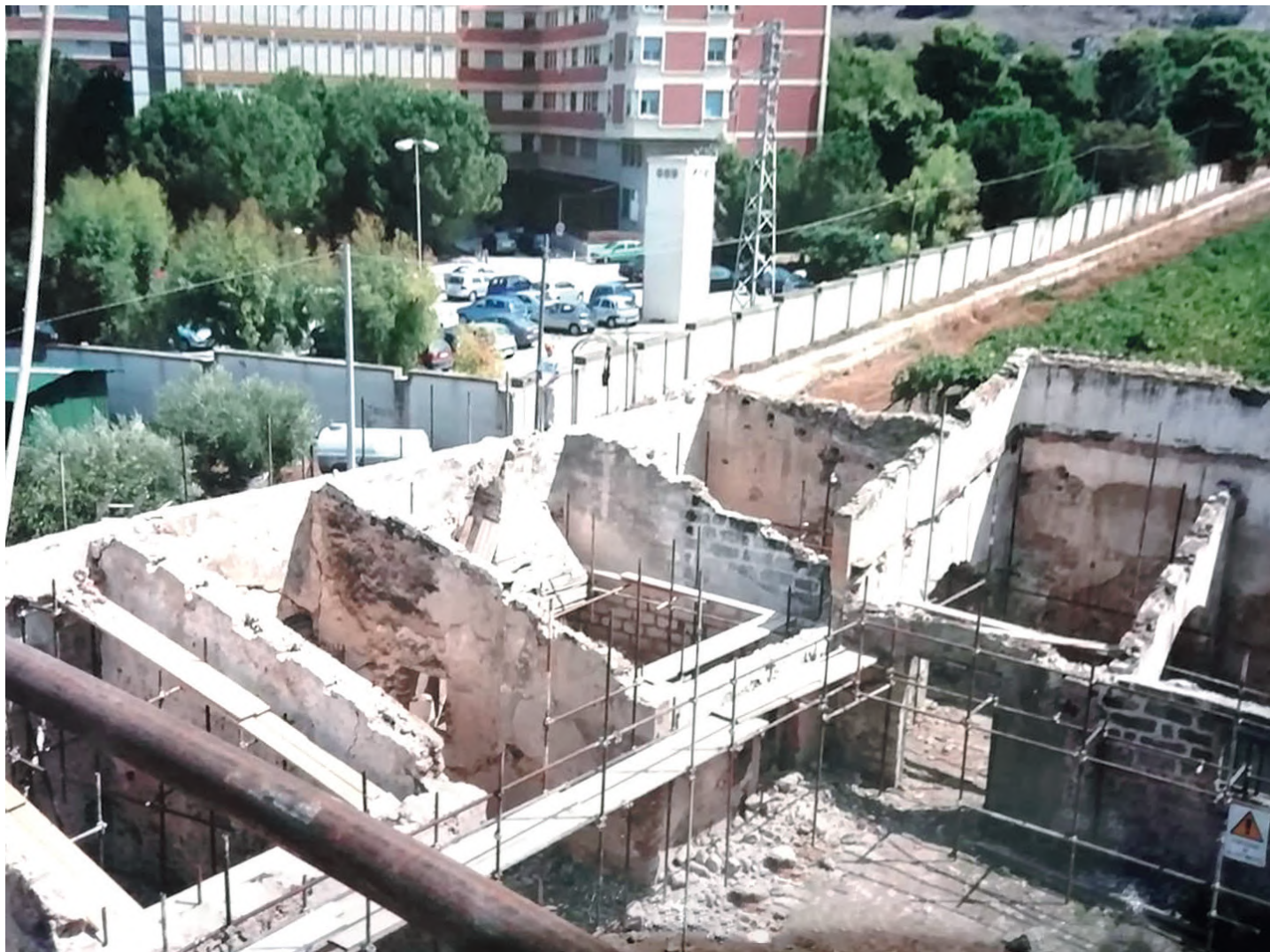
Fig. 50 -La foto prova che in un primo momento non ci si era accorti del loggiato e si era mantenuto in piedi il muro esterno (foto di Stefano Tortomasi capo cantiere)
