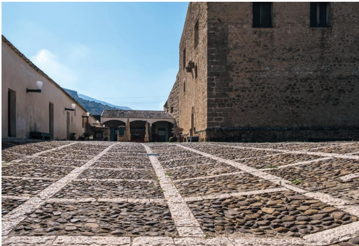
Fig. 33 - Pavimentazione esterna, oggi
