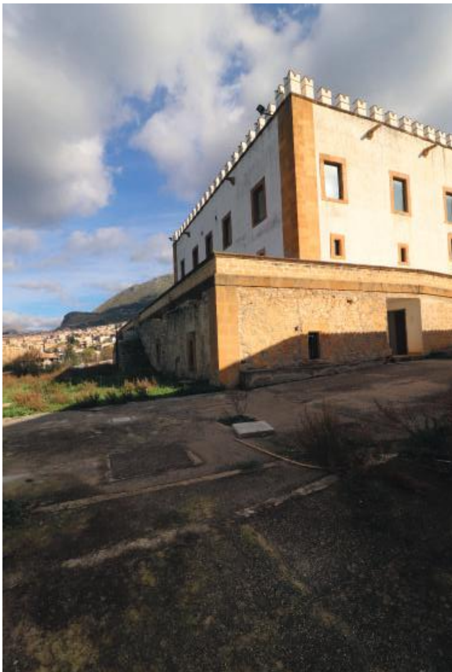
Fig. 23 - L'angolo occidentale del Palazzo con l'accesso al bunker e ai servizi
