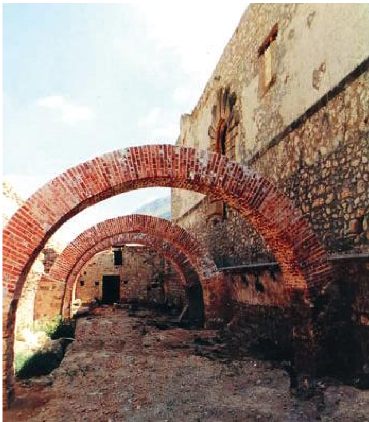
Fig. 27 - Il Palazzo Ram: la foto mostra che erano state rimosse le macerie del crollo della piattaforma e il rifacimento degli archi sostituendo la pietra de i Margi con il cotto
