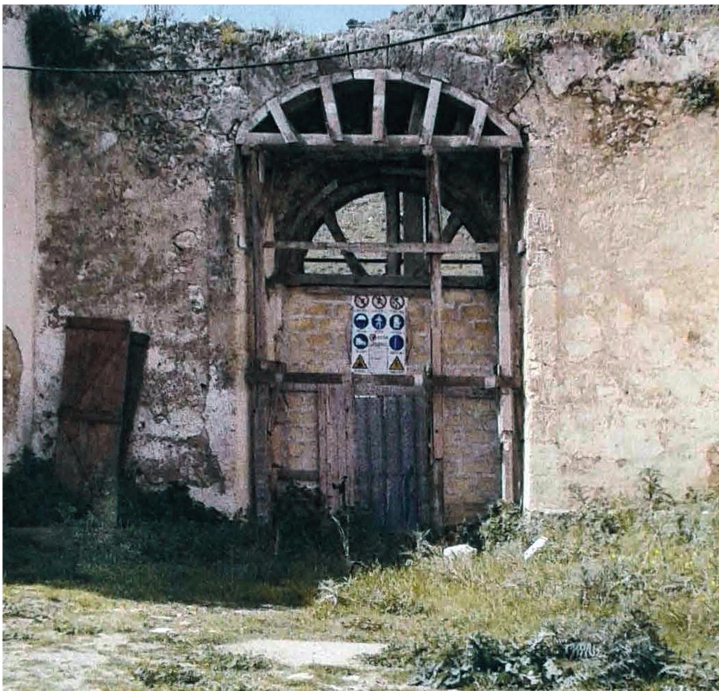
Fig. 30 - Palazzo Ram: il portone d'ingresso, prima del restauro
