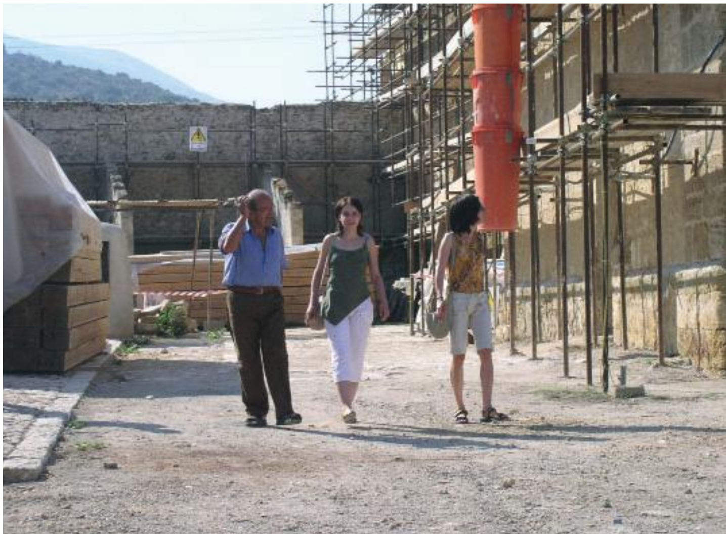
Fig. 30 - Giuseppe Casarubba durante la visita ai lavori della Real Cantina. Sullo sfondo si vede la parete interna del loggiato contenente gli affreschi
