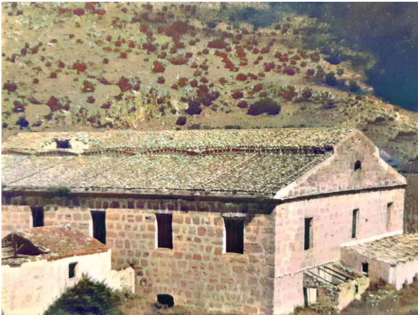
Fig. 51 - Parte posteriore della Real Cantina
