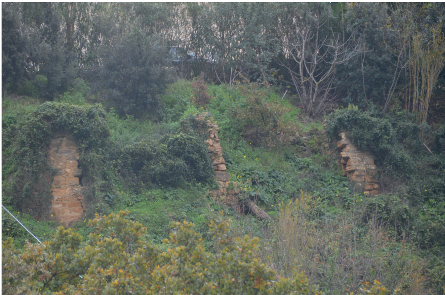
Fig. n. 17 – Residuo murario della scarpata adiacente al santuario di Maria SS del Ponte
