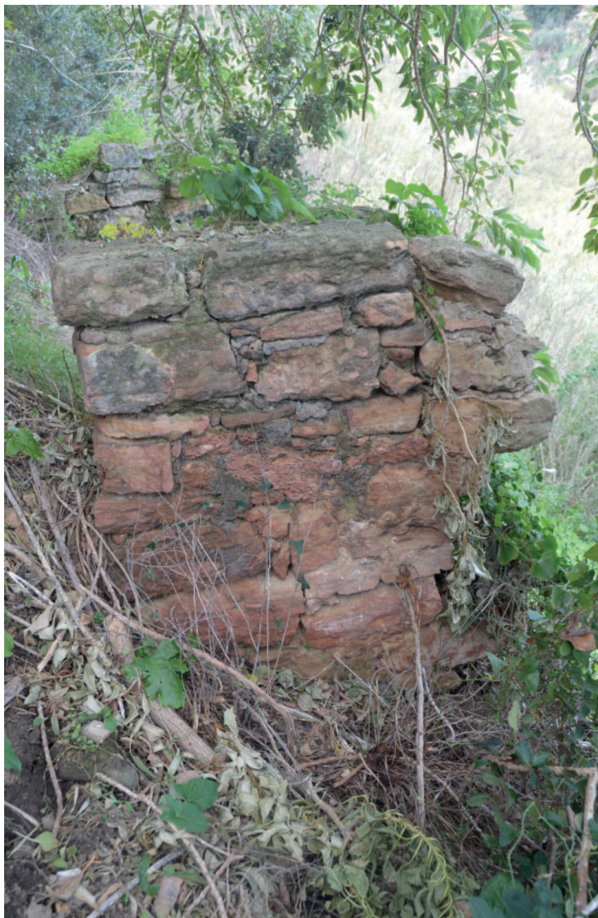
Fig. n. 18 – Parte interna del muro la cui conformazione escluderebbe la funzione di contrafforte
