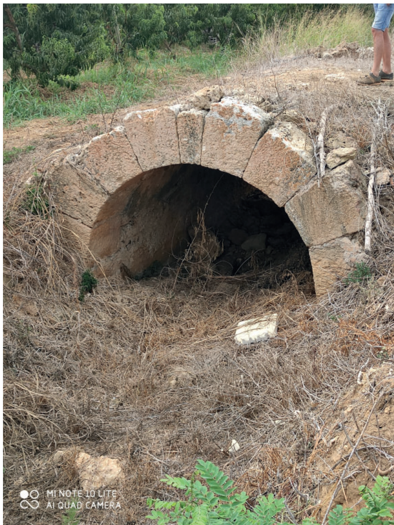
Fig. 19 - Il ponte di contrada Groppo
