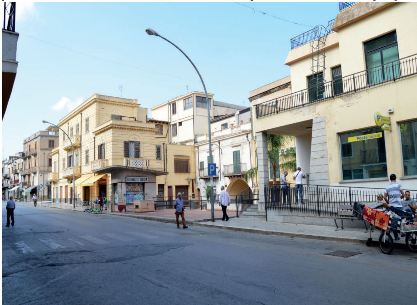
Fig. n.11 - La piazzetta antistante all'ingresso del Fondaco occupata oggi dal Palazzo delle Poste
