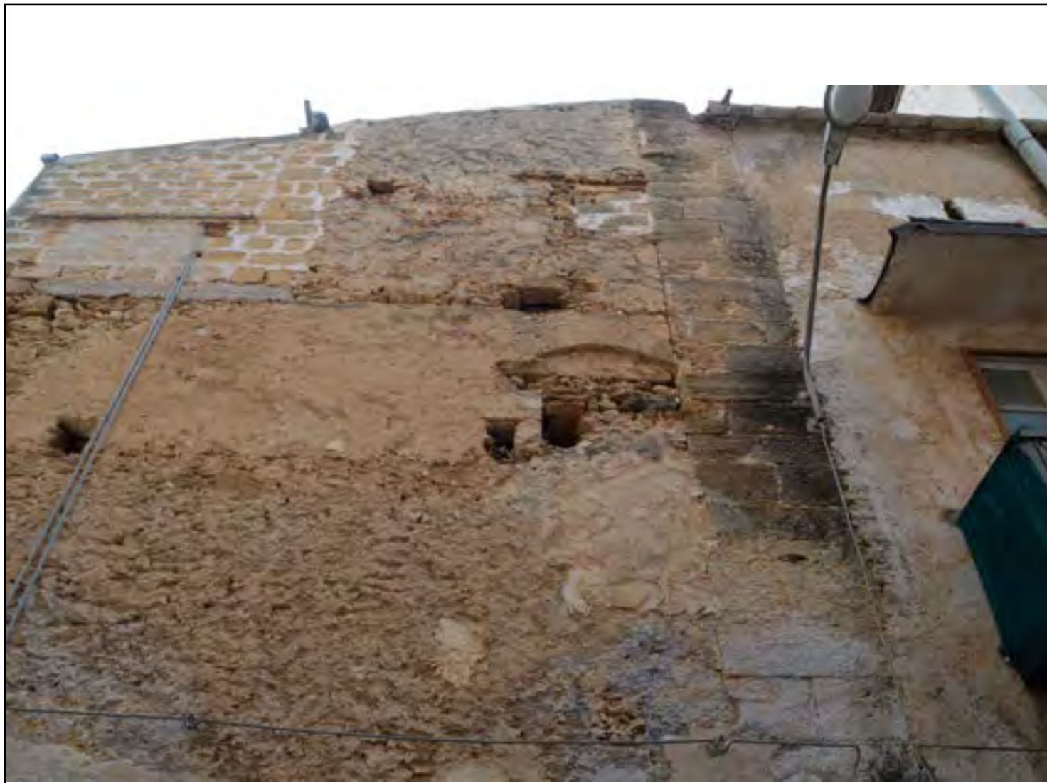
Fig. 19 - La cantunera dell'antica torre di Baddu nell'edificio del geometra Saverio Labruzzo realizzata con possenti conci di tufo
