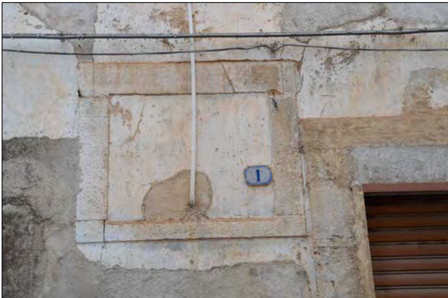
Fig. 18- La finestra cinquecentesche del magazzino sulla via Porcaro
