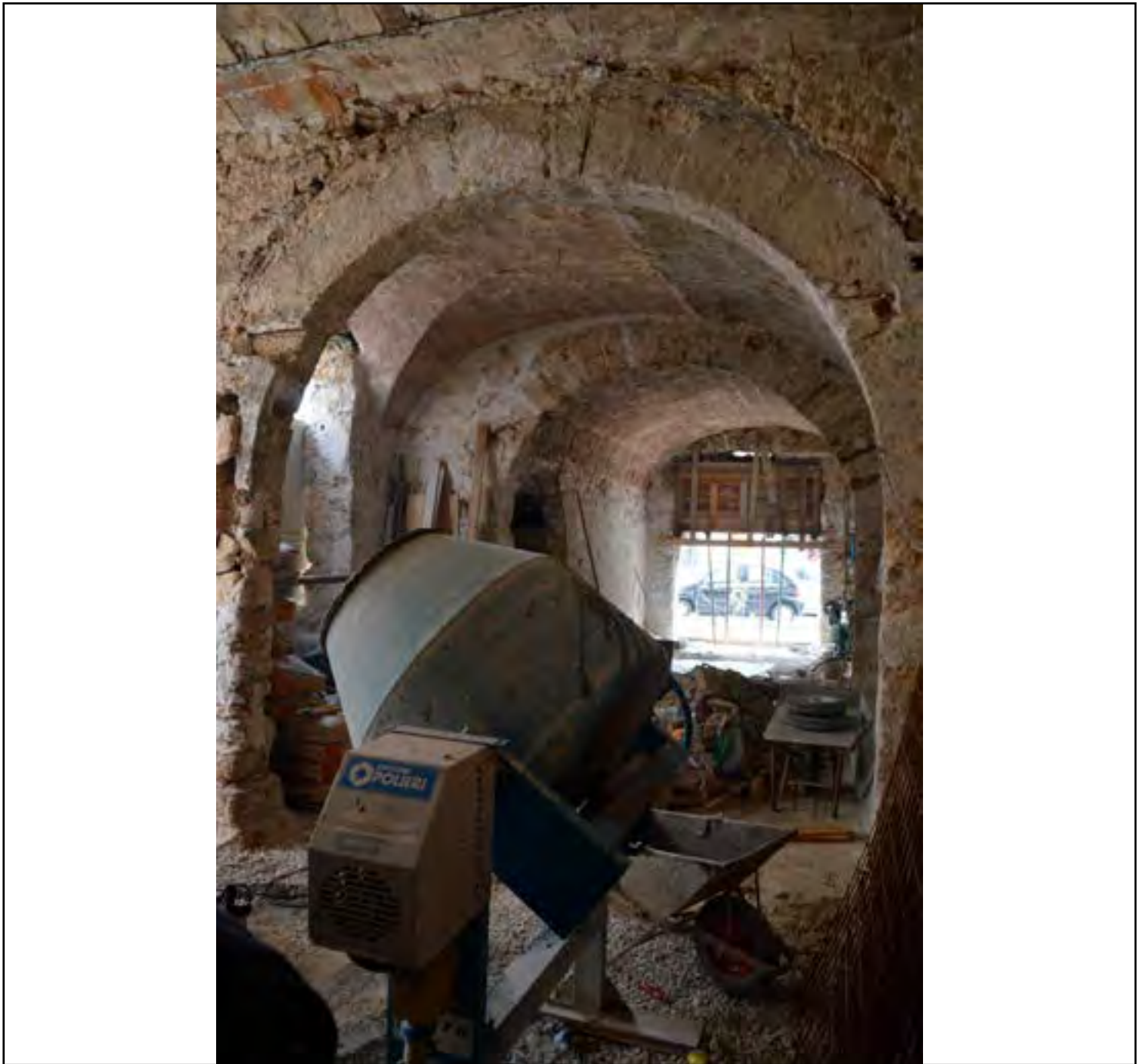
Fig. 27 - Antichi elementi architettonici messi in evidenza durante i lavori di realizzazione del bar Crema e Cioccolato
