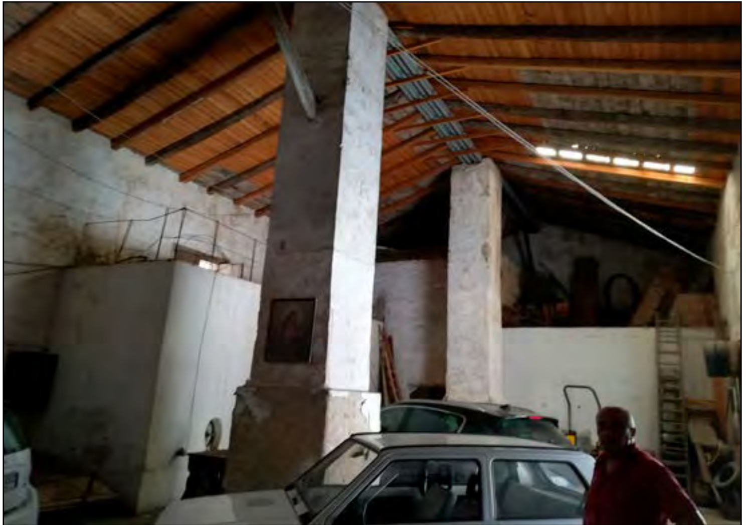
Fig. 13 - L'interno del magazzino del sig. Giacalone che conserva gli antichi pilastri in tufo rappresentati sia nella mappa antica che nel catastale odierno
