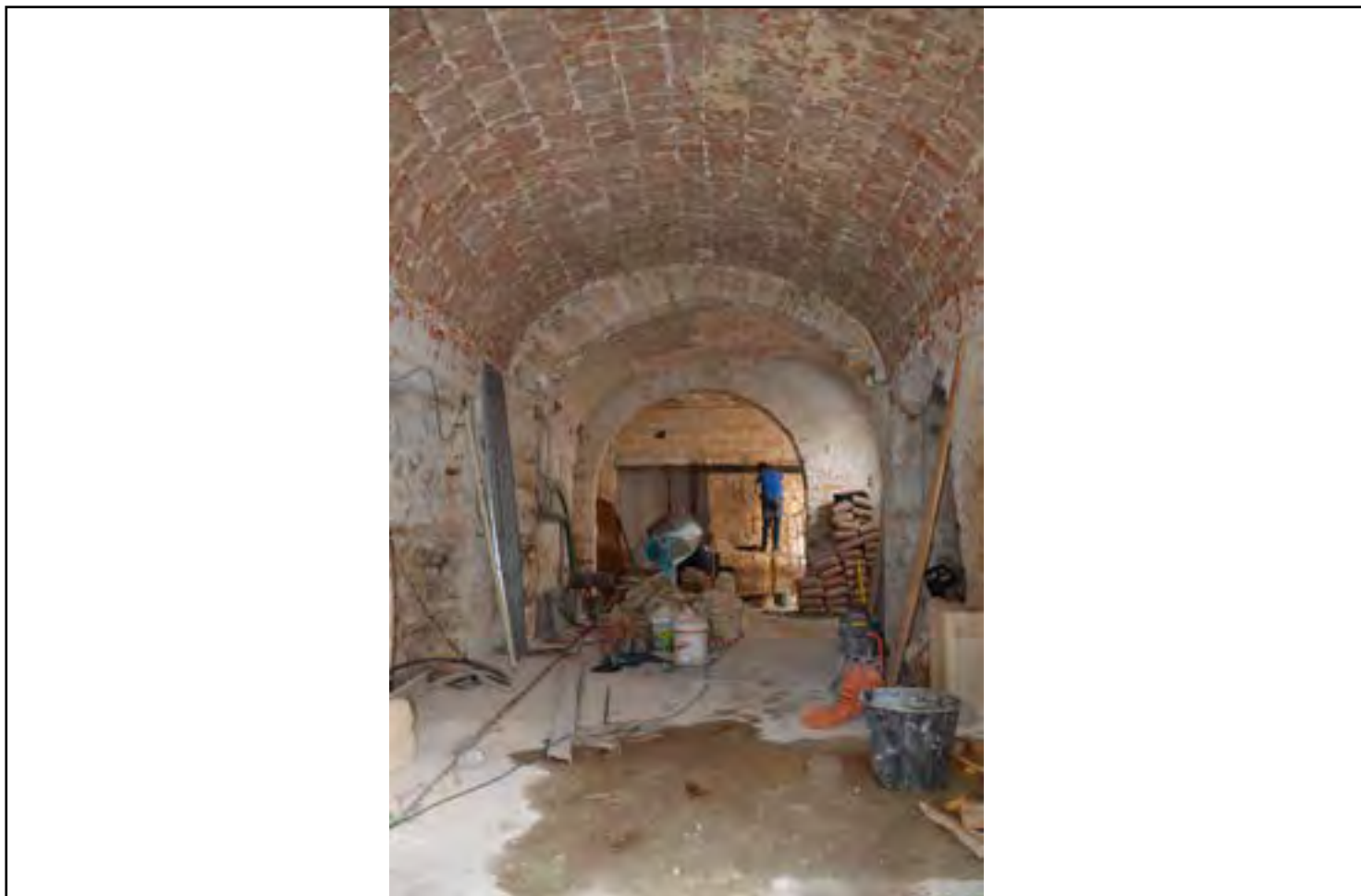
Fig. 26 - Antichi elementi architettonici messi in evidenza durante i lavori di realizzazione del bar Crema e Cioccolato
