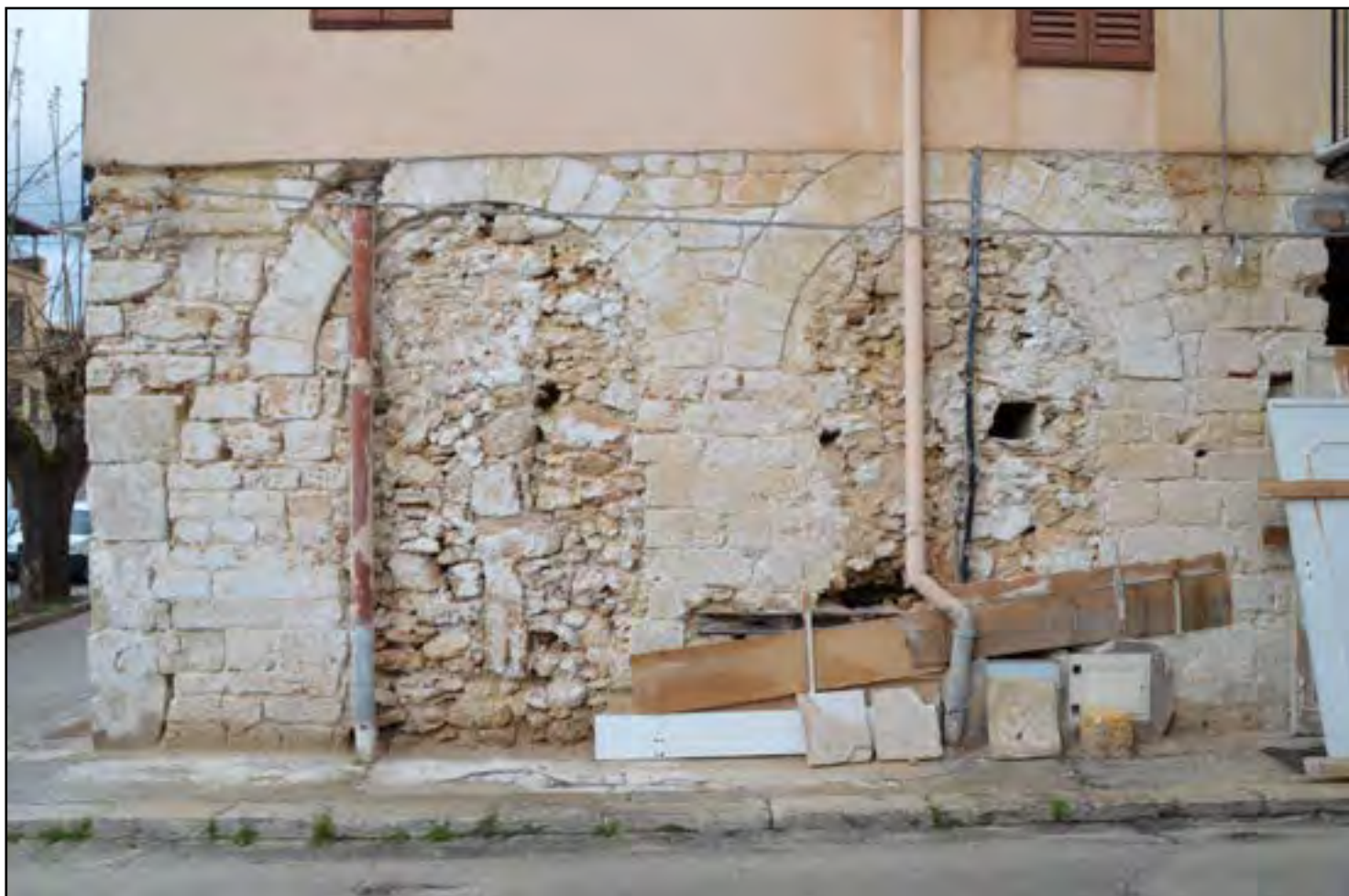
Fig. 24 - Strutture che hanno inglobato elementi architettonici precedenti della Casina Reale
