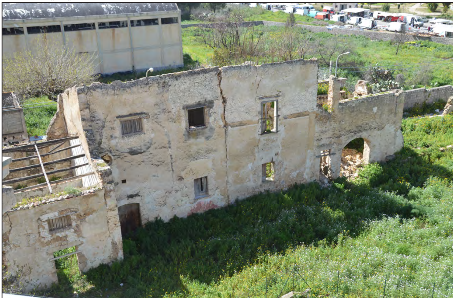
Fig. 4 - Il baglio di Gambacurta-Raccugli visto dall'interno
