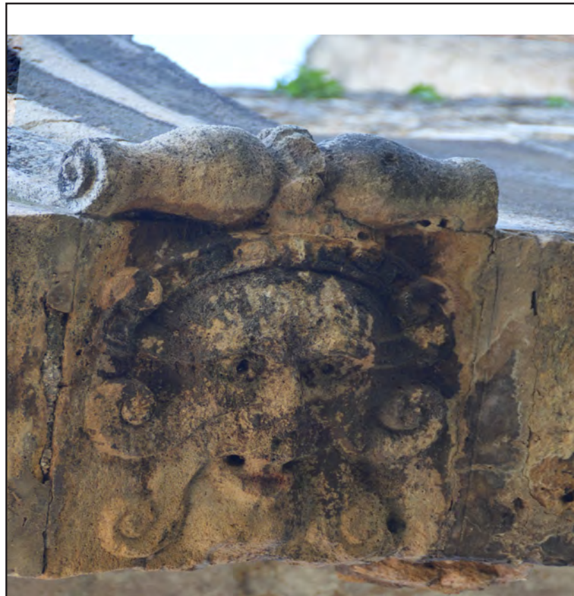
Fig. 3 - Mascherone della chiave di volta del portale d'ingresso
