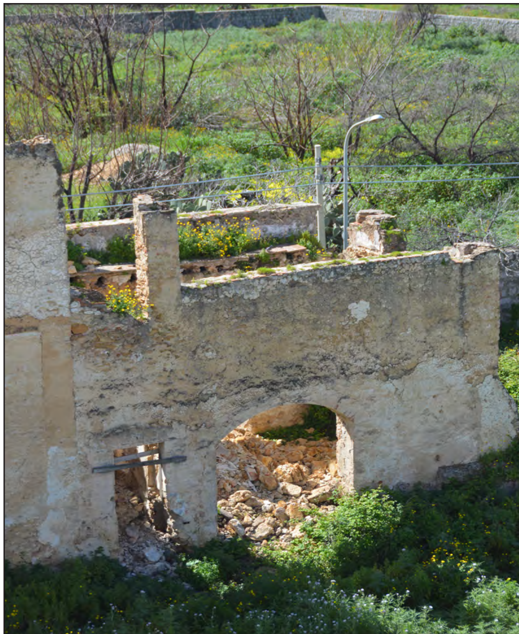
Fig. 16 - Il terrazzino adiacente alla cucina
