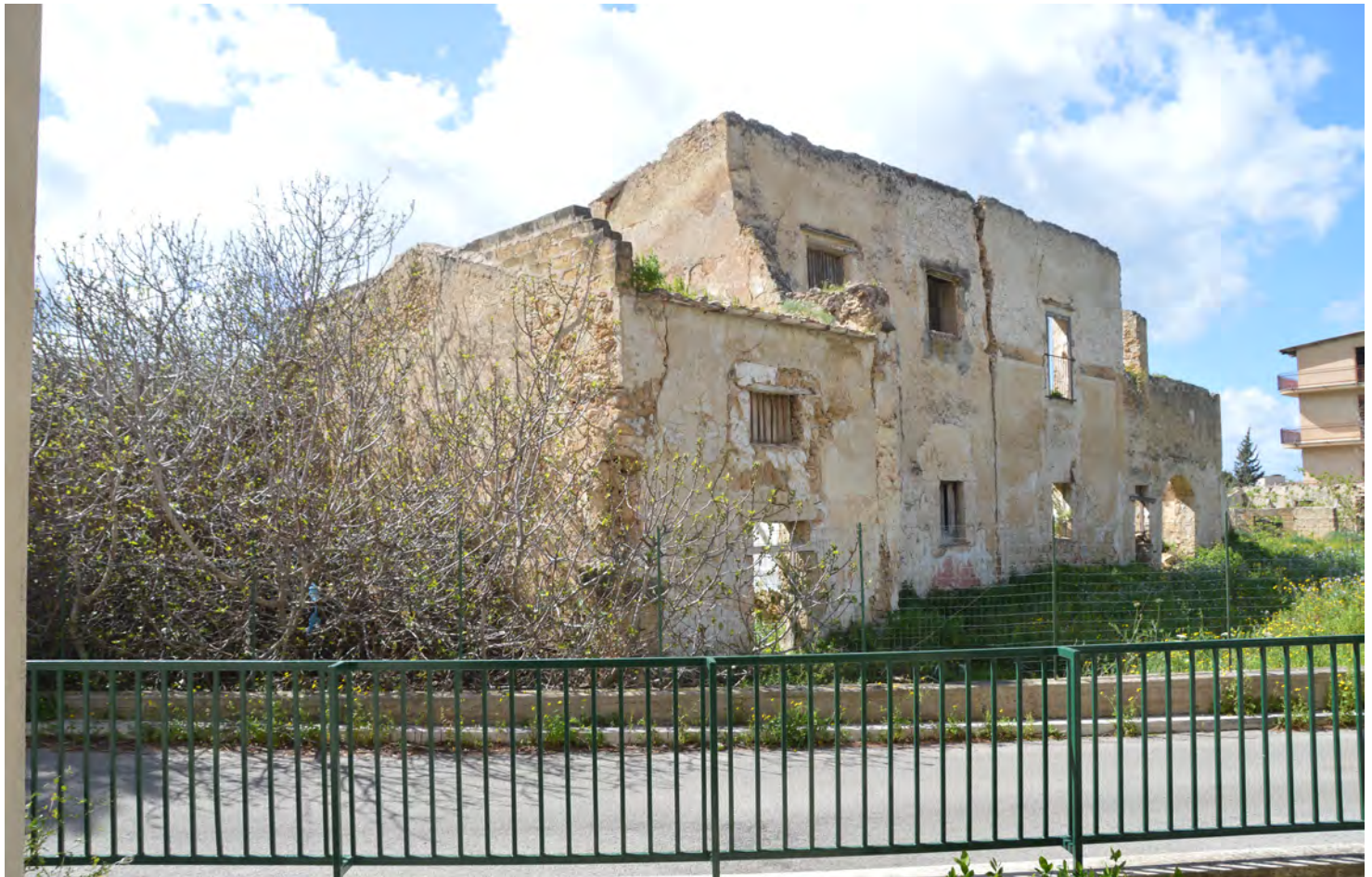
Fig. 18 - Il caseggiato del Baglio visto da sud
