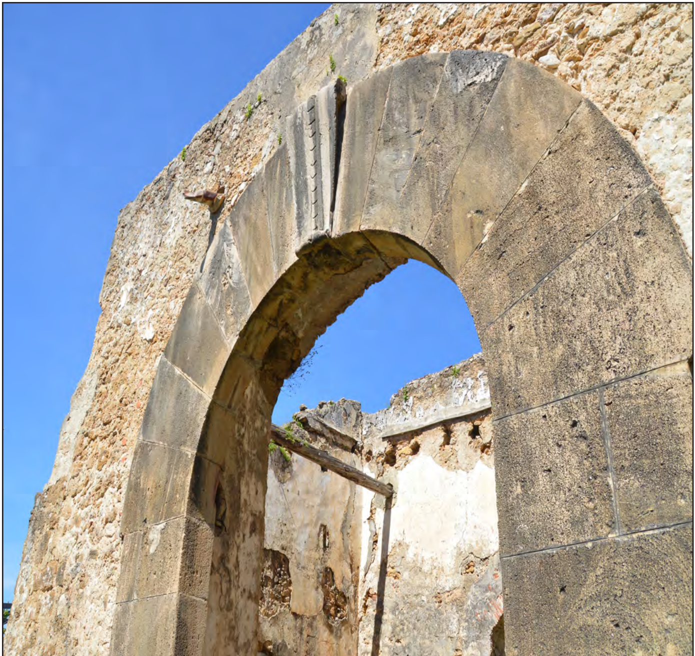
Fig. 22 - Il monumentale portale
