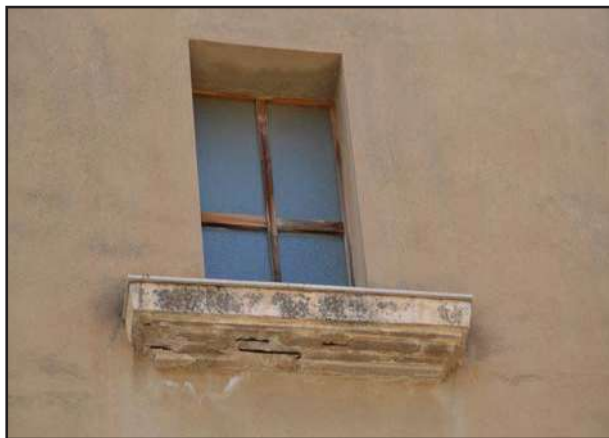
Fig. 6 - La Casa dell'Abbazia: i balconi con i gattoni in pietra e il davanzale della finestra con modanatura in cemento scoppiato
