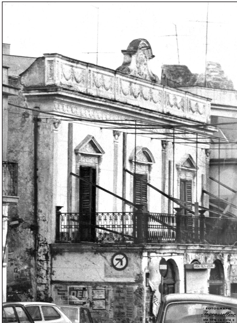
Fig. 24 - Una rara foto scattata nel novembre del 1975, poco prima della demolizione, dal maestro Ingrassellino
