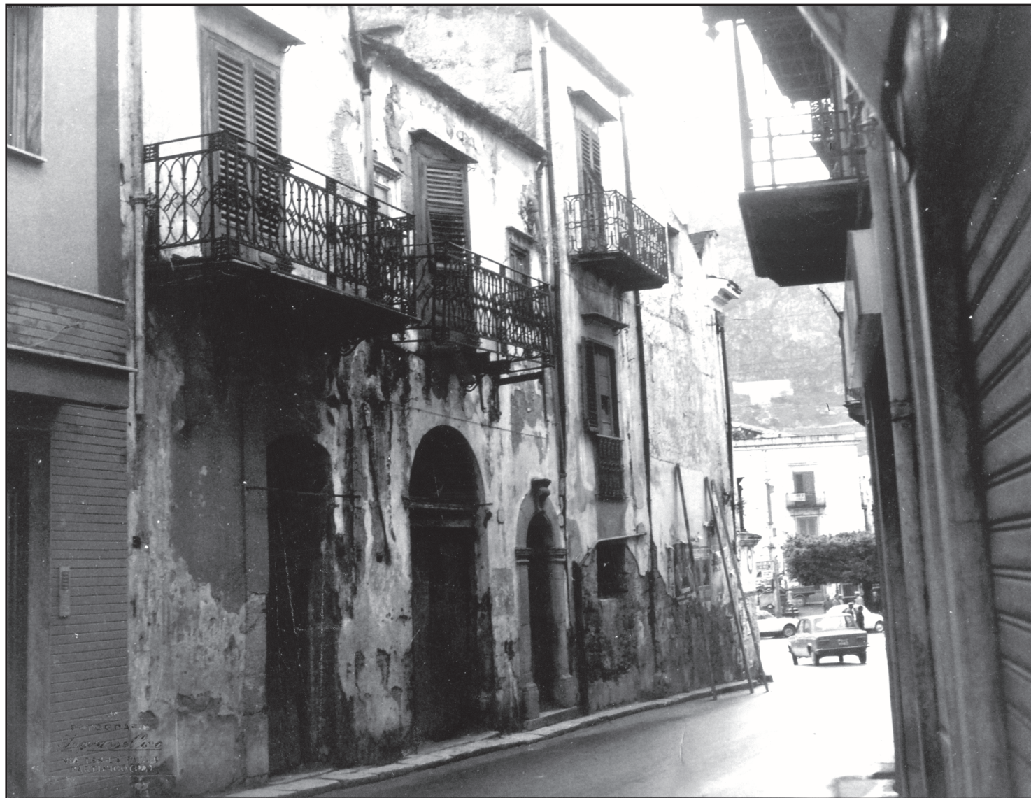
Fig. 25 - La parte iniziale della strada Granni col Palazzo Scalia con alcune tavole appoggiate per segnalare l'inesistente l'imminente pericolo di crollo
