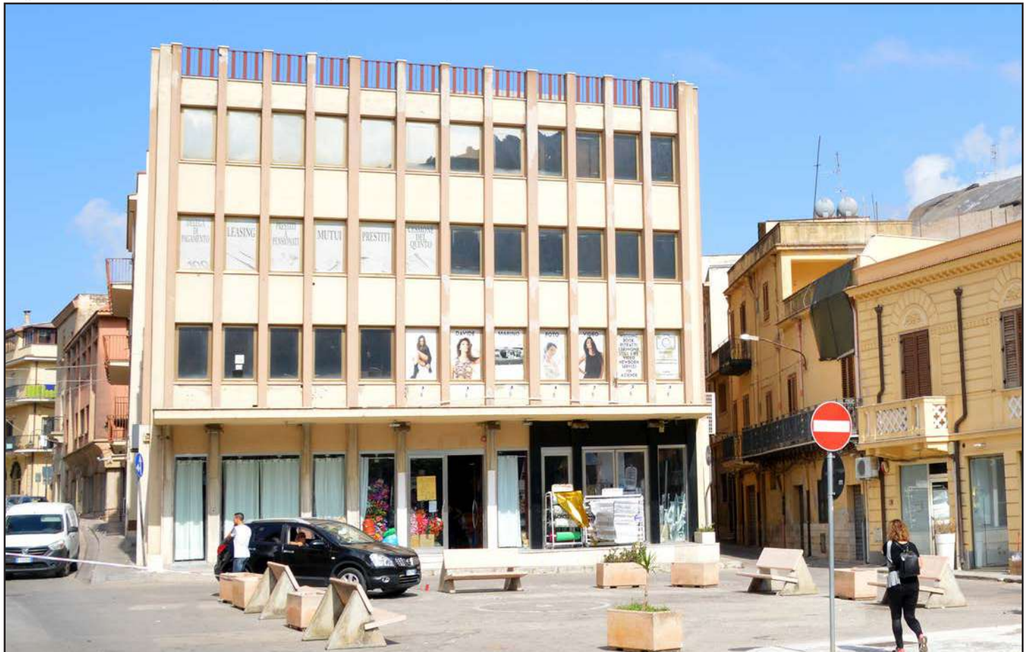
Fig. 26 - Il palazzo che ha sostituito il Palazzo Scalia
